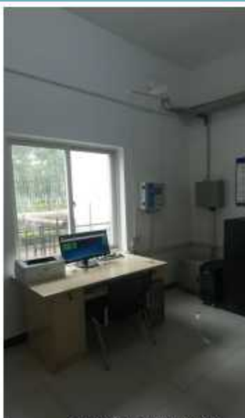
现场数据处理系统
